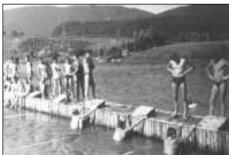
Leta 1952 je bil na jezeru narejen bazenu podoben objekt. Ograjen je bil s treh strani, ob strani pa je bil postavljen še skakalni stolp. Zgrajena sta bila še dva manjša bazena za otroke, na dno katerih so položili leseno podlogo.
